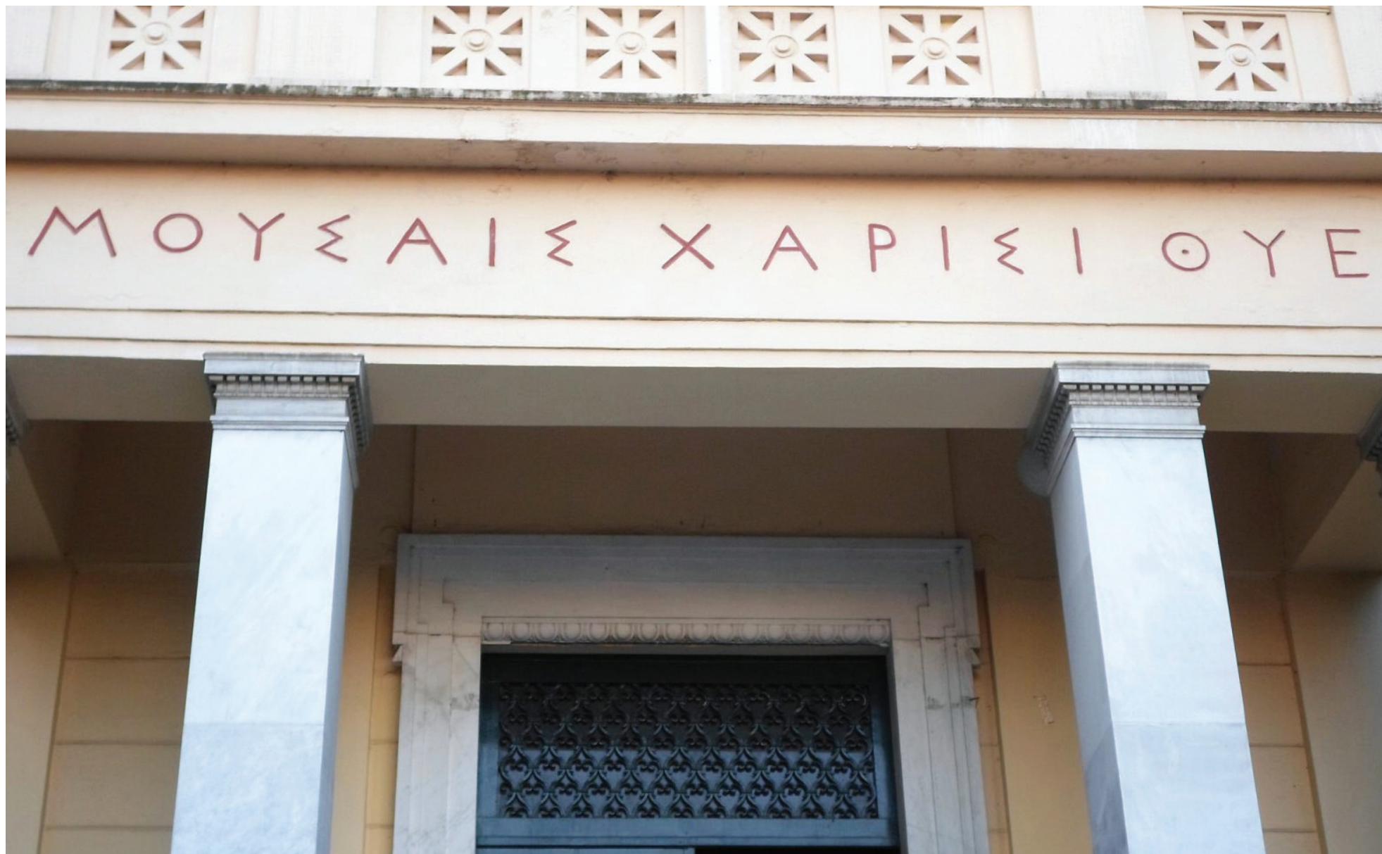
Είσοδος Παλαιού Κτιρίου Φιλοσοφικής Σχολής
